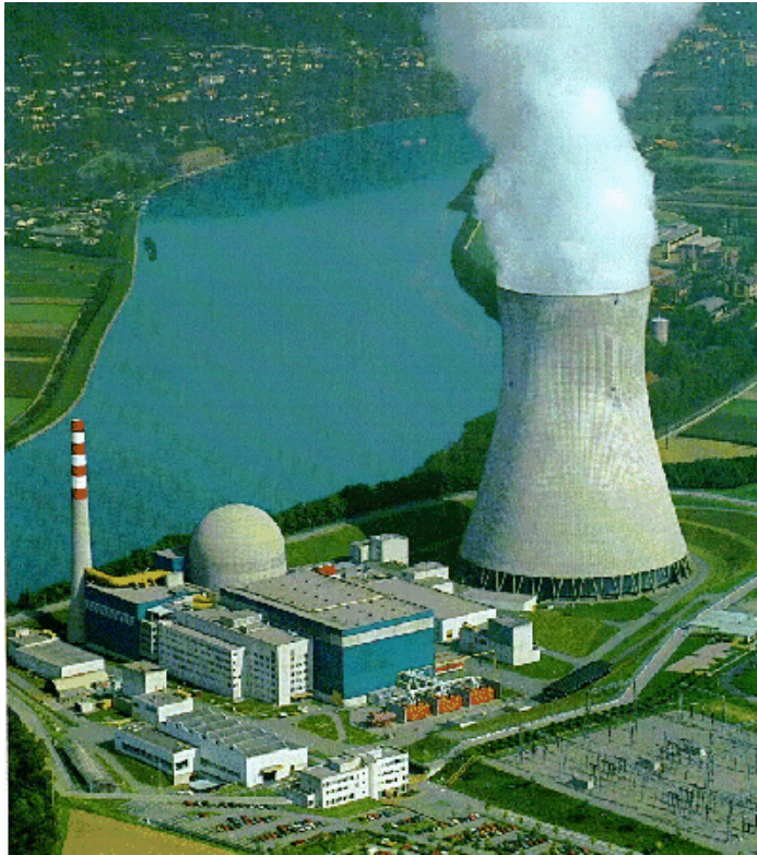
Εικ. 1 Πύργος Ψύξης Σταθμού Παραγωγής Ηλεκτρικής Ενέργειας
